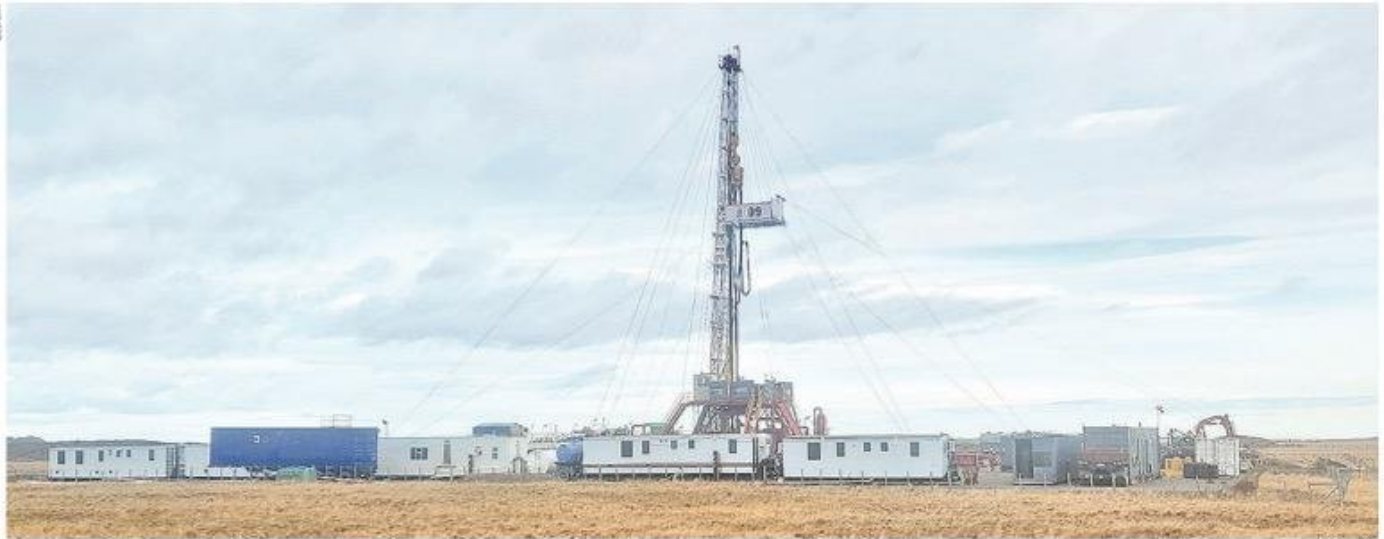
Equipo de perforación en pozo exploratorio Koo x-1
