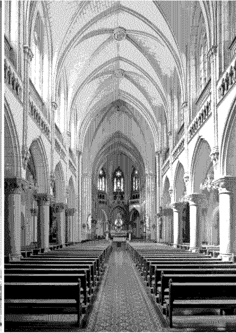
Formada por tres naves, la central mide 12 metros de ancho y las laterales, seis.
