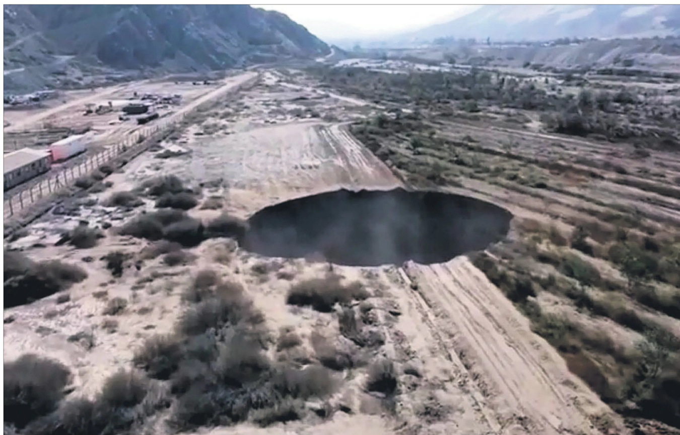
Socavón de Tierra Amarilla.
