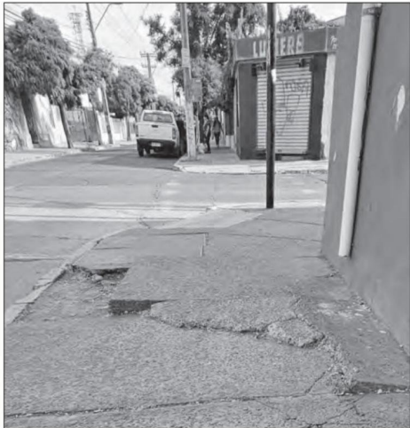
En la esquina de Blanco con La Concepción queda en evidencia el problema de las veredas.
