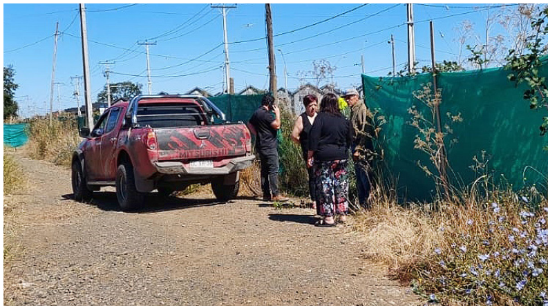
El canal fue construido junto con las últimas viviendas de avenida Villarrica y afecta a los vecinos de villas Conavicoop y Las Praderas de Labranza.
