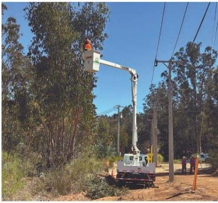
DENTRO DE LAS LABORES ESTÁ EL DESPEJE DE RAMAS.
