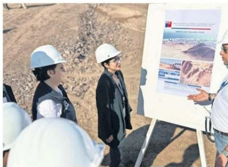
AUTORIDADES VISITARON EL LUGAR DE LAS OBRAS.
