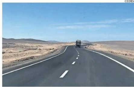
EL TRAMO SUMA 20 NUEVOS KILÓMETROS DE PAVIMENTO.
