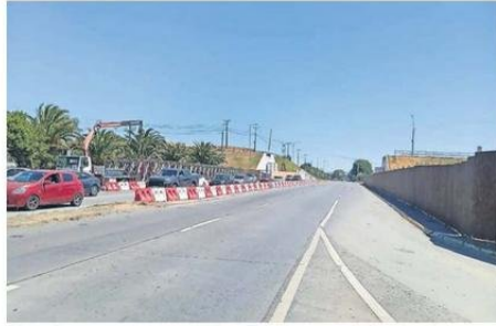
Durante una semana se realizará el desarme de la estructura.
