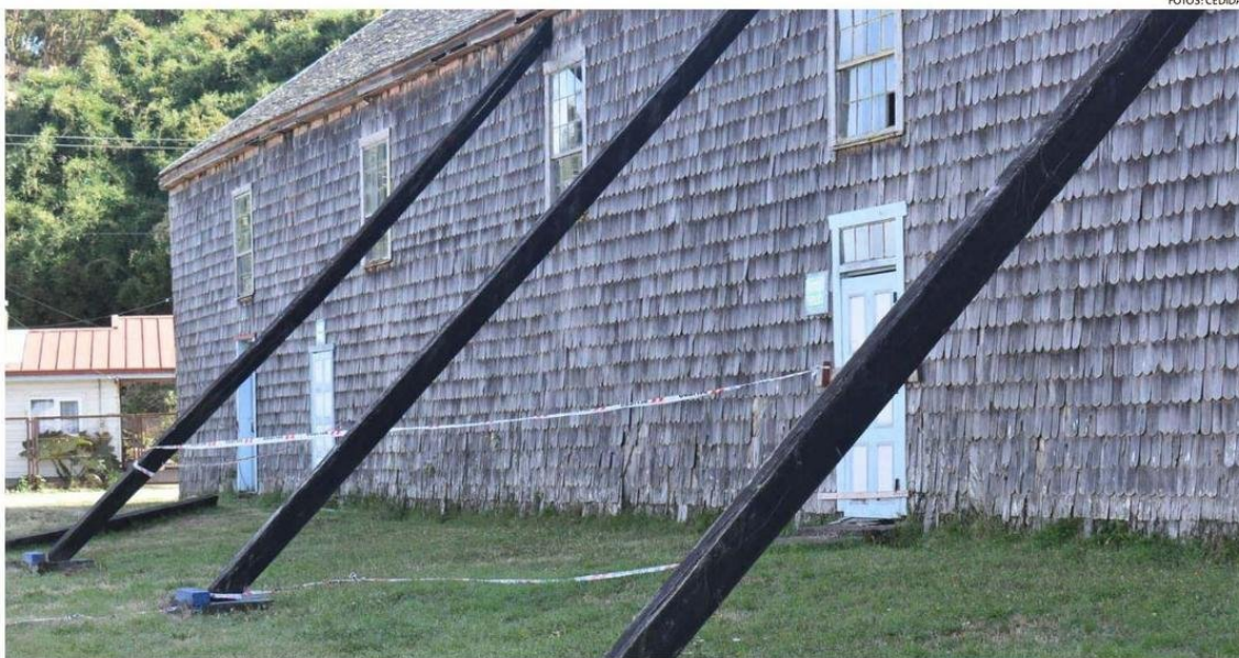
AYER PARTIÓ LA EJECUCIÓN DE OBRAS DE EMERGENCIAS EN LA IGLESIA JESÚS NAZARENO DE CAGUACH (ABAJO), LA QUE SUFRE DEFORMACIONES LATERALES (ARRIBA).
