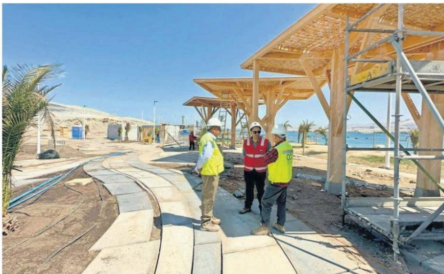
LAS OBRAS LLEVAN UN 67% DE AVANCE EN SU CONSTRUCCIÓN.
