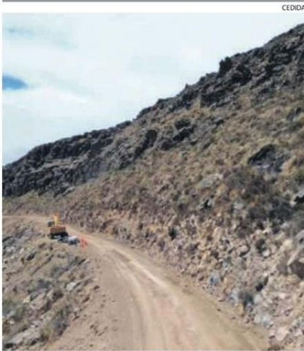
EN LA RUTA A-575 SE REALIZAN LAS OBRAS DE CONSERVACIÓN.
