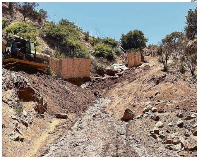
EMPRESA MANTIENE TRABAJOS PARA REEMPLAZAR EL TRAMO DEL COLECTOR, LO QUE FINALIZARÁ PRÓXIMAMENTE.
