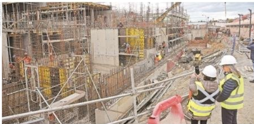
La estructura del nuevo Cesfam ya comienza a tomar forma y se puede apreciar cuánto se ampliarán los espacios de atención al público.
