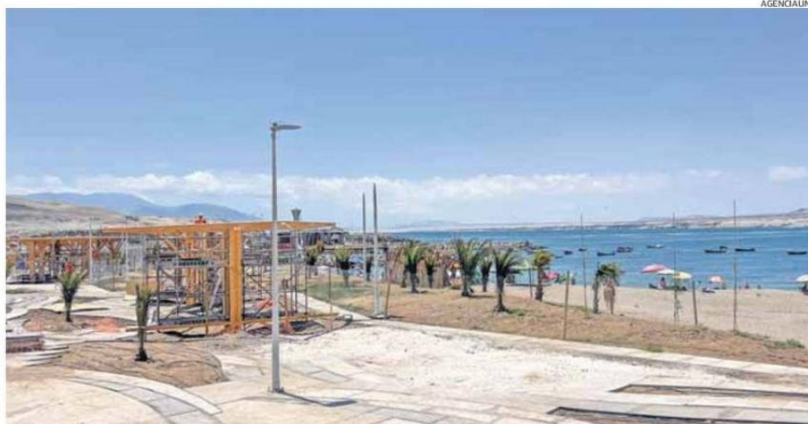
LA INICIATIVA PRESENTA UN 67% DE AVANCE FÍSICO Y CONTRIBUIRÁ A MEJORAR EL ACCESO Y EL ENTORNO DEL SECTOR.
