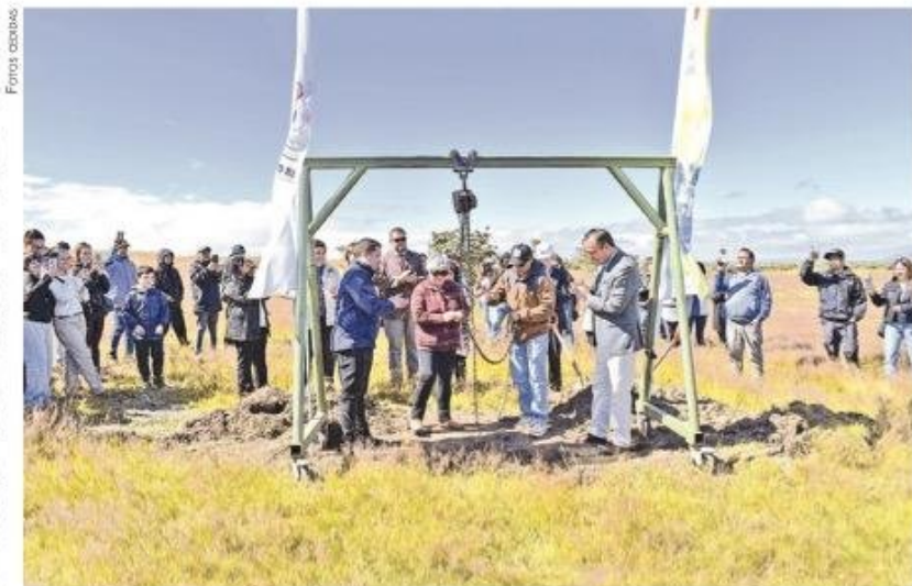
El gobernador Jorge Flies encabezó la ceremonia de instalación de la primera piedra de las casas que se construirán en los proyectos habitacionales Fjordos del Sur 1 y 2.
