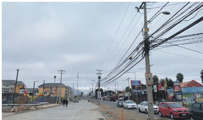
Los trabajos de mejoramiento del tramo de Cuatro Esquinas, entre la ruta 5 y la Avenida del Mar, fueron entregados durante el año pasado.
