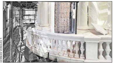
Detalle de las obras al interior del inmueble.
