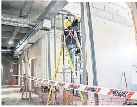
CONSTRUCCIÓN DE PABELLONES EN EL HOSPITAL HIGUERAS.
