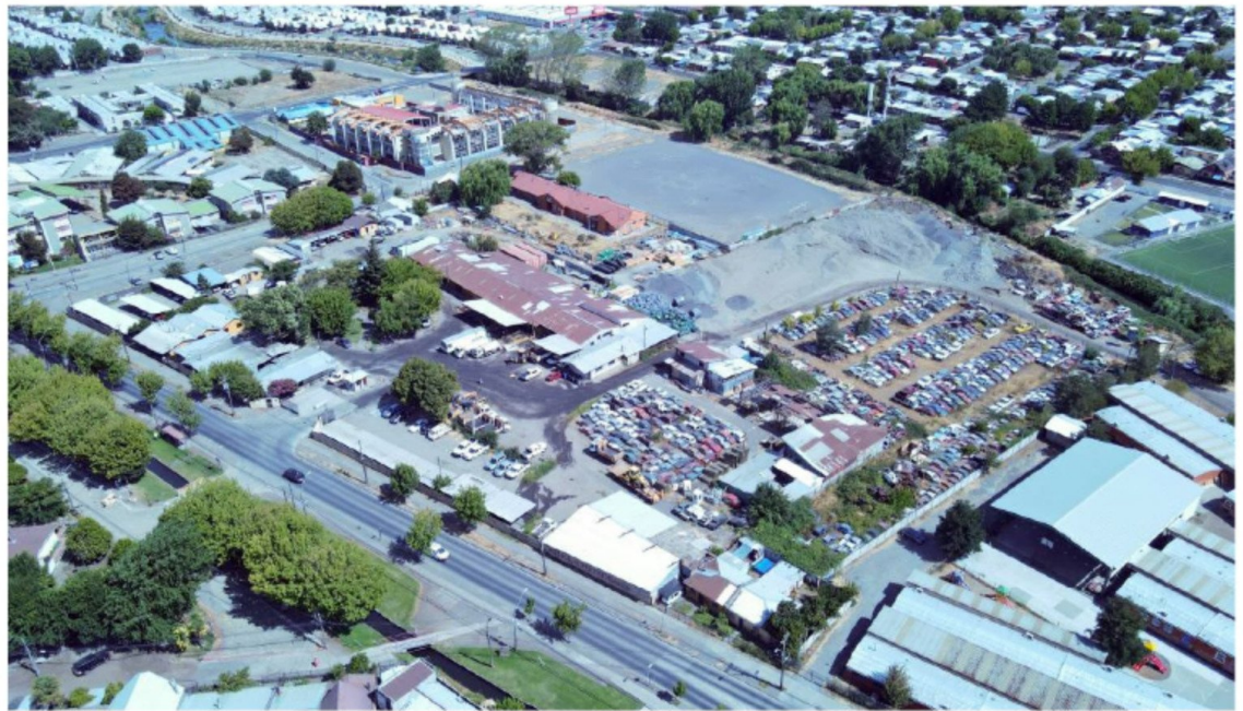
EL TERRENO DE LOS CORRALONES MUNICIPALES DE CALLE COLO COLO fue la primera opción evaluada para emplazar el nuevo hospital, pero fue descartado porque su espacio era insuficiente.
