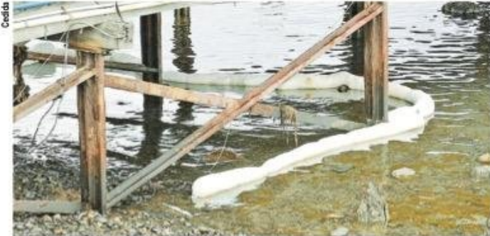
Muestra de los dispositivos que fueron utilizados para captar el material combustible.
