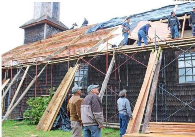
LA IGLESIA DE CALEN, SOMETIDA A ARREGLOS EXTERIORES EN EL 2023, TENDRÁ FAENAS ESTE AÑO EN EL PISO, LA TORRE Y DE IMAGINERÍA.
