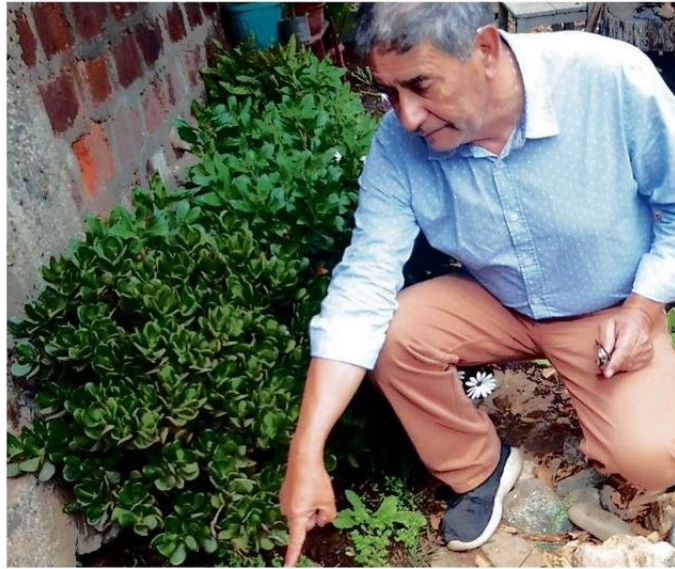
LAS FILTRACIONES DE LA CASA CONTIGUA CONTAMINAN EL PATIO DE ESTE VECINO DE CARTAGENA.
