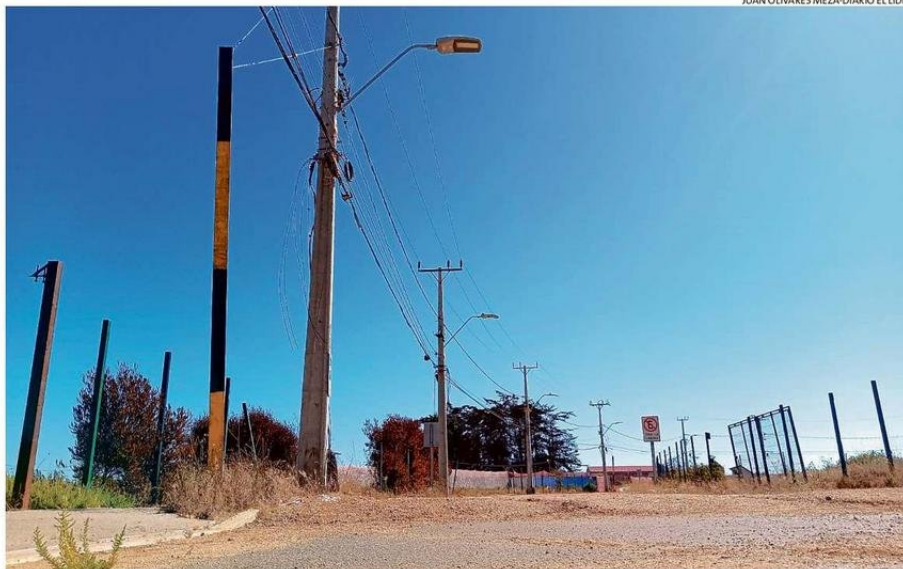
CALLES INUTILIZADAS Y EL ALUMBRADO PÚBLICO ABANDONADO SON LO ÚNICO QUE QUEDA DE MIRADOR EL FARO TRAS LA DEMOLICIÓN.
