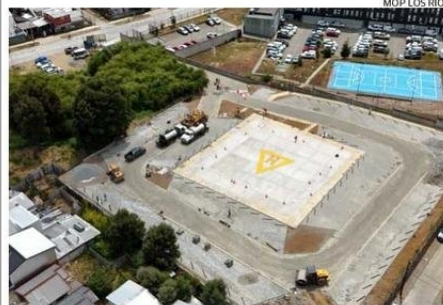
LA ESTRUCTURA INCLUYE UNA BASE DE HORMIGÓN DE 27 METROS CUADRADOS.
