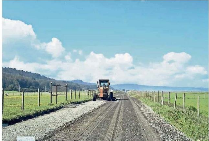
TODA LA RUTA COSTERA DE COBQUECURA TENDRÁ PAVIMENTO, LO QUE POTENCIARÁ EL TURISMO.
