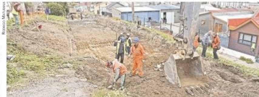
Por fin los vecinos de calle Marchant comienzan a ver los trabajos de pavimentación de su calle.
