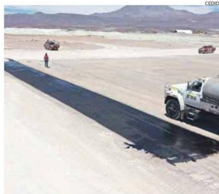
TRABAJOS PARA HABILITAR LA POSADA DE HELICÓPTERO EN OLLAGÜE.
