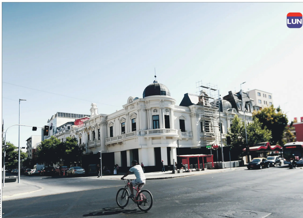
La centenaria edificación está ubicada en Alameda con Ejército.
