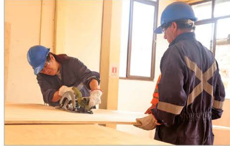
Becas Laborales Técnicas constructivas domiciliarias e Instalación de pisos flotantes y cerámicos.
