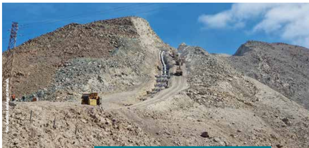
Nueva Centinela - Trabajos en Quebrada del Diablo.
