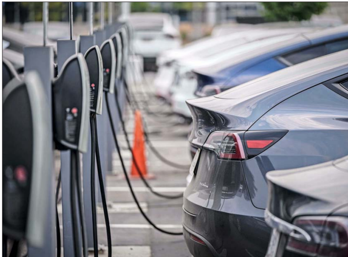
Las baterías son, por lejos, el componente más caro de un vehículo eléctrico.
