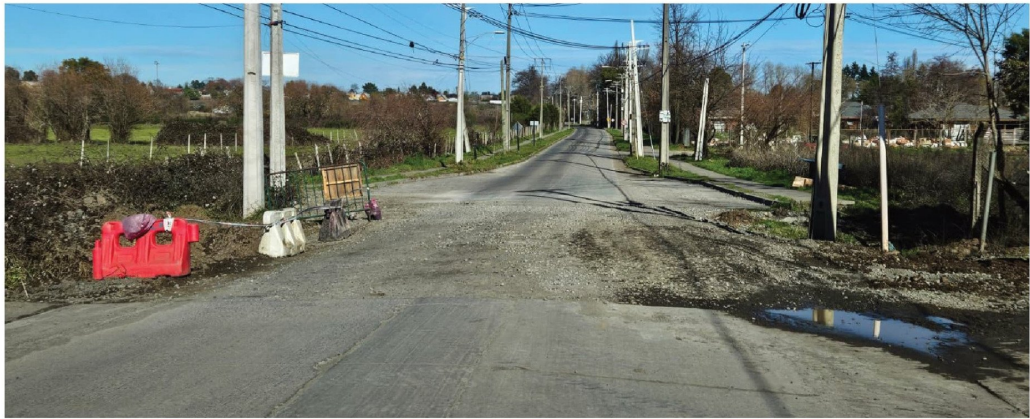
EL PUENTE SOBRE el estero El Bolsón no fue construido por demoras administrativas y la quiebra de la empresa encargada.
