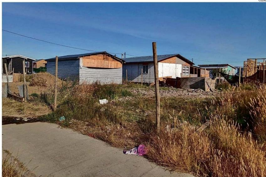
LAS CONSTRUCCIONES IRREGULARES FUERON ADVERTIDAS POR EL DELEGADO MUNICIPAL DE ALERCE, QUIEN ALERTÓ DEL RIESGO DE INCENDIO.
