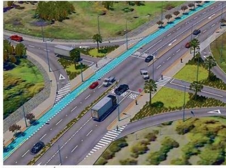
OBRA MEJORARÁ LA CONECTIVIDAD DE LA PROVINCIA DE PETORCA.
