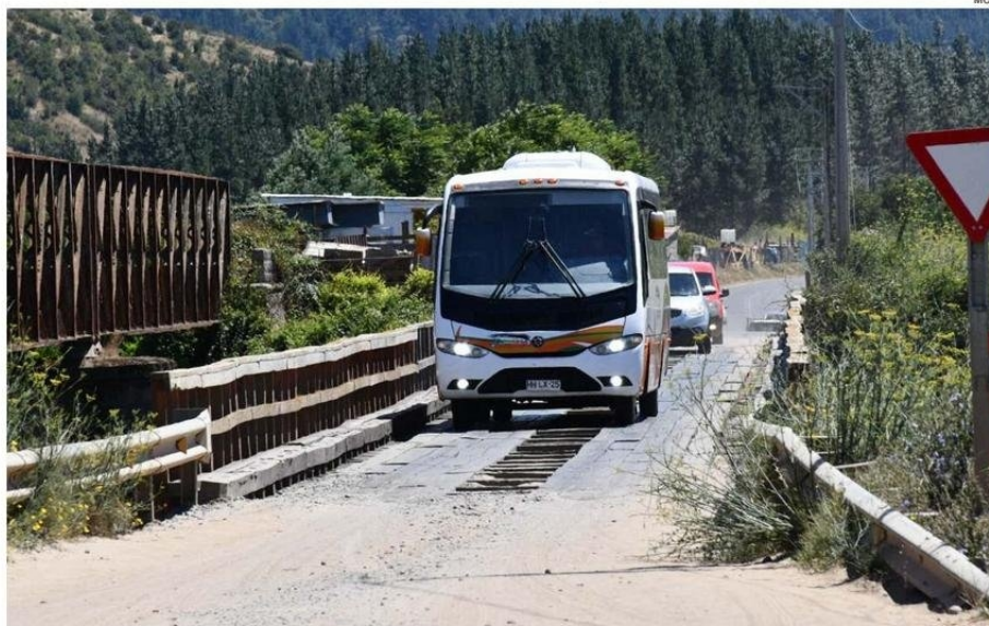
LA REPOSICIÓN DEL PUENTE MALLECO SE PROYECTA EN UNA LONGITUD DE 125 METROS. ESTE NUEVO VIADUCTO CONSIDERA UNA INVERSIÓN DE 12.345 MILLONES DE PESOS.
