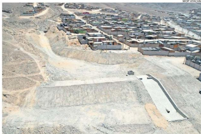
LOS TRABAJOS A CARGO DE LA DOH ALCANZARON UNA INVERSIÓN APROXIMADA 426 MILLONES DE PESOS.
