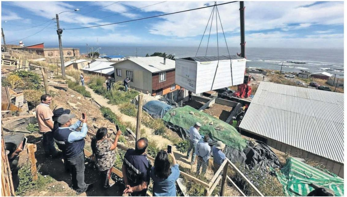
Las viviendas industrializadas tienen un plazo cercano a los 90 días en cuanto al proceso de adquisición e instalación hasta su entrega a la familia beneficiada.
