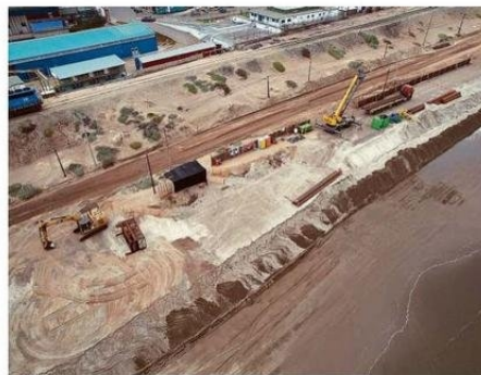
DESALINIZADORA DE AGUAS PACÍFICO EN QUINTERO-PUCHUNCAVÍ.
