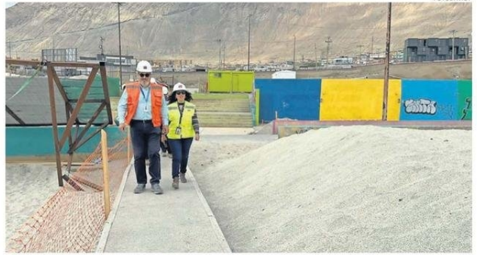
LOS TRABAJOS FINALIZARÁN EL PRIMER TRIMESTRE DE ESTE AÑO, INFORMÓ EL MOP.
