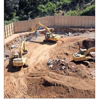
El trabajo de descontaminación ambiental que se desarrolla en el lugar.
