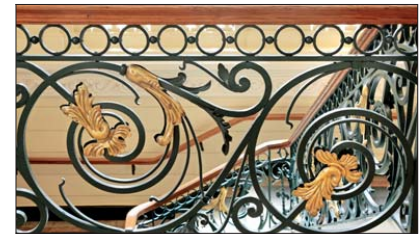
El edificio está plagado de detalles. La restauración recuperó los colores originales de las barandas, y también descubrió los dorados y brillos de antaño.
