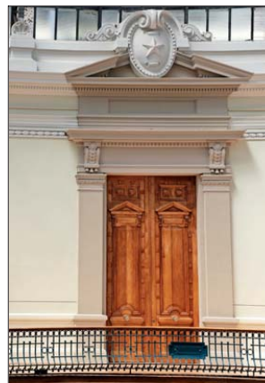
El proyecto incluyó la restauración de las 19 puertas de lingüe de doble hoja, que conectan con el vestíbulo central y los espacios comunes del museo.
