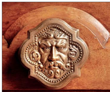
Durante las obras se descubrió el brillo de las chapas, así como de los escudos dorados que están en los vértices del hall. Estaban cubiertos con capas de suciedad o, en algunos casos, pintura.
