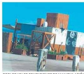
DEPLORABLES CONDICIONES DE MANIPULACIÓN.
