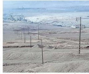
NUEVA AFECTACIÓN AL SUMINISTRO ELÉCTRICO.
