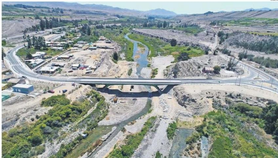
EL PUENTE NICOLASA SE UBICA SOBRE EL RÍO HUASCO, EN LA RUTA C-530. EN LA COMUNA DE FREIRINA.
