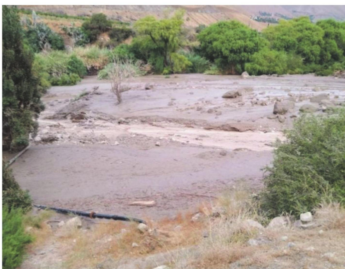
La activación de la quebrada La Viga provocó graves daños en el Sistema Sanitario Rural del lugar, dejando a 3.200 personas sin suministro de agua potable.
