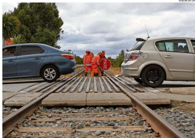
OPERARIOS DE EMPRESAS CONTRATISTAS DE EFE, REALIZAN EL MEJORAMIENTO DE LOS CRUCES FERROVIARIOS.
