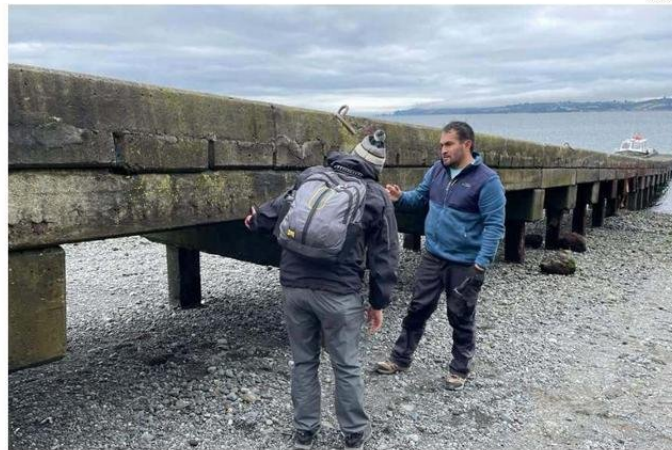
HAY UN AÑO DE PLAZO PARA MATERIALIZAR LA RAMPA QUE DEBE CONSTRUIR LA FIRMA ICEAL SPA.
