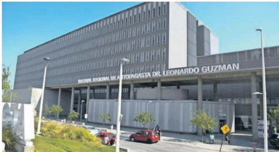
VAN MÁS DE 30 CIRUGÍAS QUE SE HAN TENIDO QUE SUSPENDER POR LA FALLA DEL SISTEMA DE CLIMATIZACIÓN.
