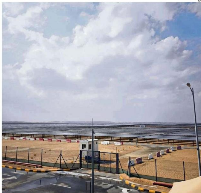
LA PLANTA FOTOVOLTAICA MÁS GRANDE DEL MUNDO YA SE ENCUENTRA EN ABU DABI.
